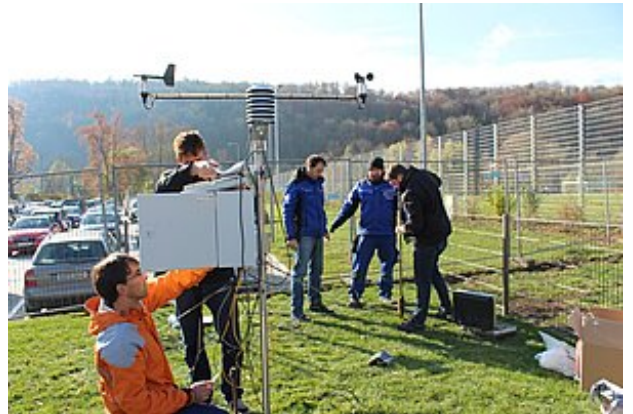
Aufbau der Wetterstation am 9.11.16 (Bild: Tabea Klier)
