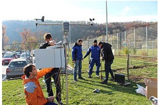
Aufbau der Wetterstation am 9.11.16 (Bild: Tabea Klier)
