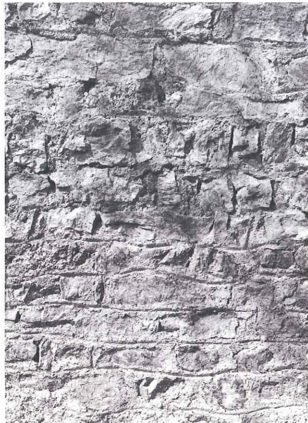
Stromberg, Burgkapelle. Durch Fugenstriche getrennte Steinlagen der Nordwand.
