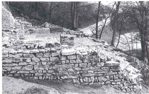
Stromberg, Burgkapelle. Die Außenseite der Westwand.
