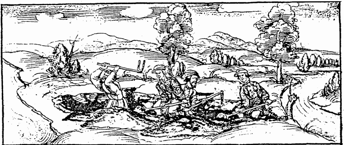
Darstellung der Bauarbeiten am Karlsgraben in einer Chronik der Würzburger Bischöfe von 1546
