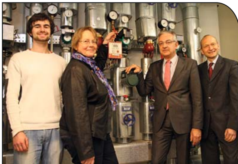
(v.r.) KU-Kanzler Thomas Kleinert, Wolfgang Brandl (Geschäftsführer der Stadtwerke Eichstätt), Prof. Dr. Ingrid Hemmer (Nachhaltigkeitsbeauftragte der KU) und Johannes Bauermann (Leiter des Bereichs Umweltmanagement) bei einem Ortstermin im Heizraum der Teilbibliothek „Aula“, die bislang mit Erdgas versorgt wurde. Für dieses und sieben weitere Gebäude wurde nun ein Vertrag zur Belieferung mit Biogas geschlossen.
