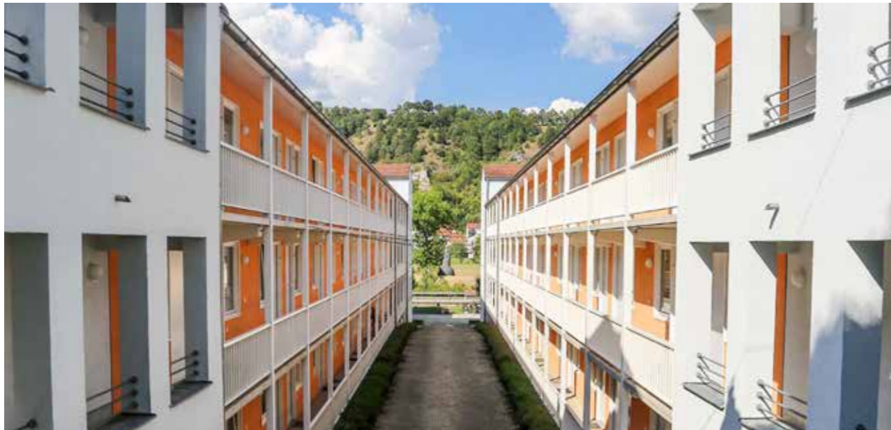
Studierendenwohnheim Freiwasser in Eichstätt
