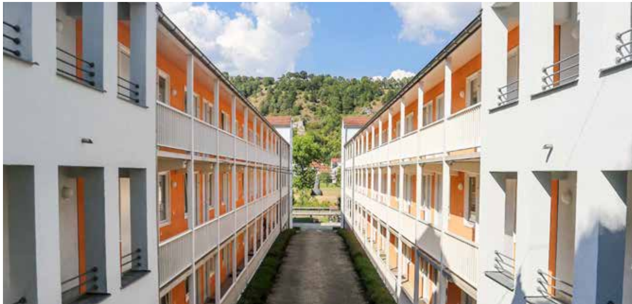
Studierendenwohnheim Freiwasser in Eichstätt
